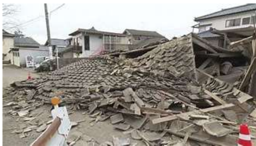
住み馴れた家屋が倒壊
