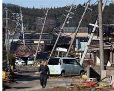
電気・通信施設の破壊
