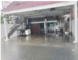
側溝も機能してなく、玄関前も水浸し
