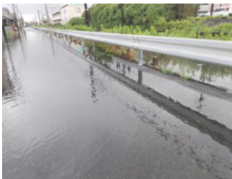
線路側に側溝が無く、名鉄線敷地と道路が一体
