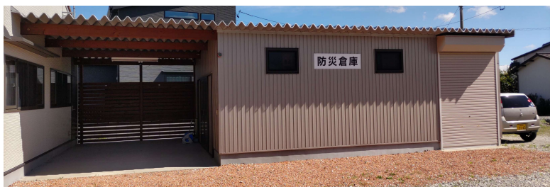
既設の防災倉庫
