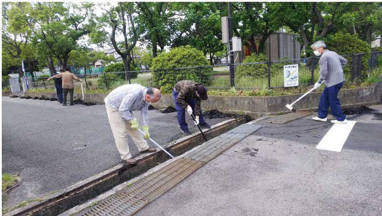
連結のグレーチングを外しての泥上げ作業
